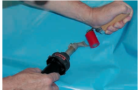
HOT-JET S ile havuz örtüsünün tamiri.
