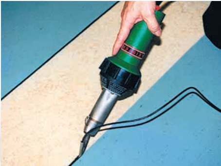
Hız kaynak nozullu TRIAC S el kaynak makinası.
